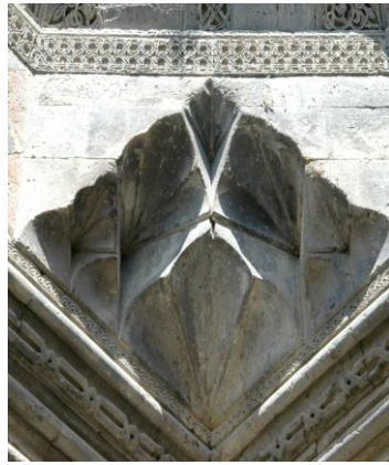
Նկ.7. ա. Շթաքարային տրոմպ. Հայրավանք
