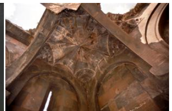
Նկ.24. Բագնայր. շթաքարային զարդով տրոմպային անցումներ
