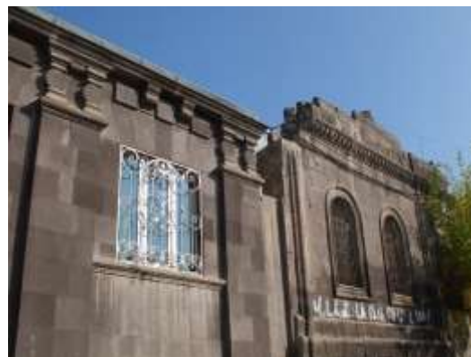
Илл. 20. Новый и старый дома из черного туфа на улице Шираза. Фото автора, 2018
