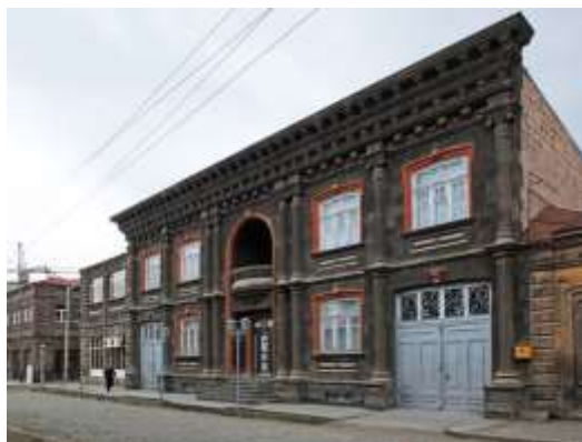
Илл. 19. Дом постройки 2000-х гг. на ул. Абовяна – реплика «Дома с 2 карнизами». Фото автора, 2017
